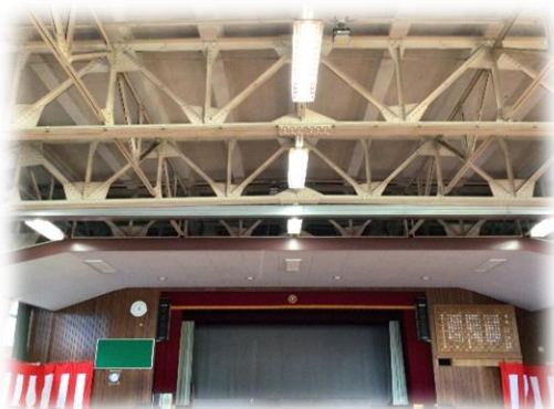
鉄骨トラスで大空間が 確保された講堂 【昭和 11 年 (1936) 建築】
